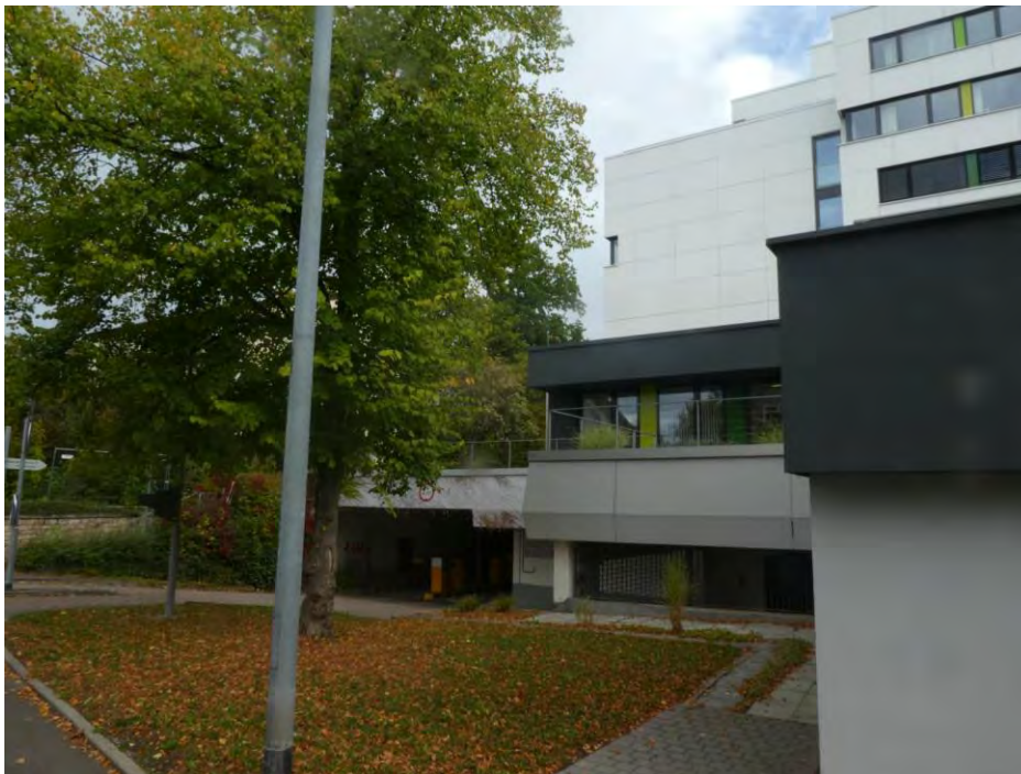
Abbildung 1: Bestandsgebäude Winnender Straße 27
